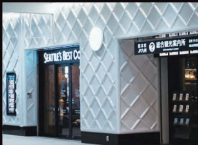
完成したなまこ壁
